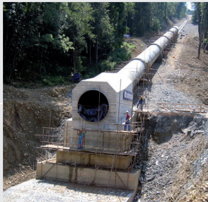
Tlačni cevovod – med gradnjo
