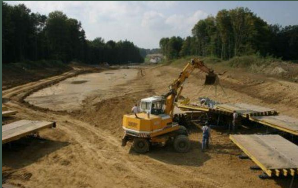
Gradnja pomurskega kraka avtoceste
